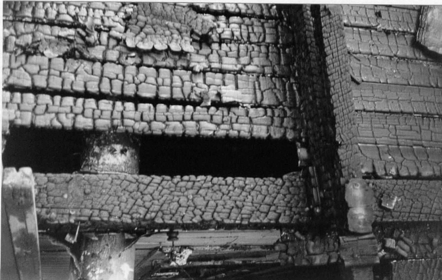
**La madera carbonizada se encoge, agrieta y abomba.**
