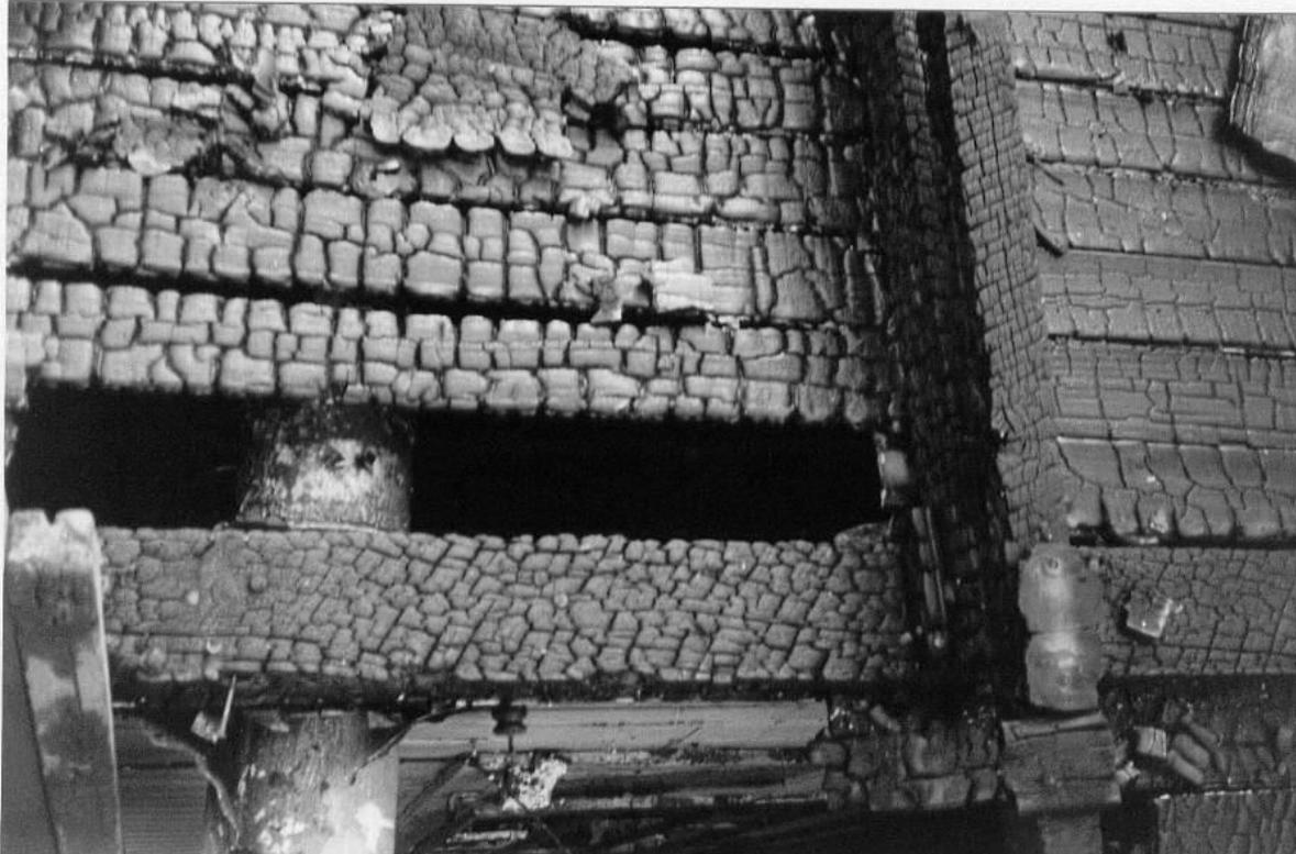
Pirólisis es la transformación de un elemento sólido debido al calor. La pirólisis precede generalmente a la combustión.
